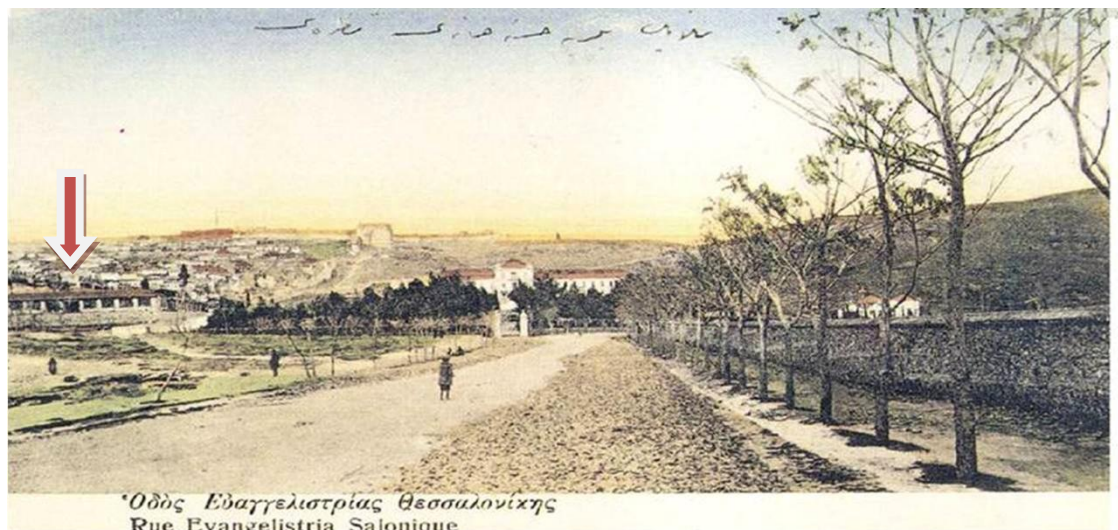
Το Εργαστήριο της Σχολής Τεχνών και Επαγγελμάτων (αρχές 20ού αιώνα).
