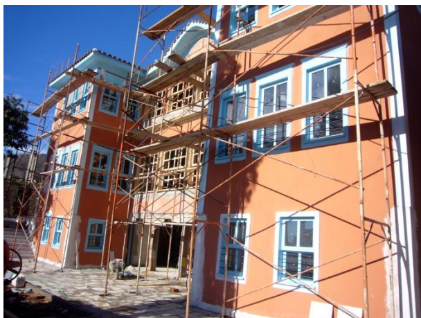
Κονάκι Μουζαφέρ βέη. Εργασίες αποκατάστασης.
