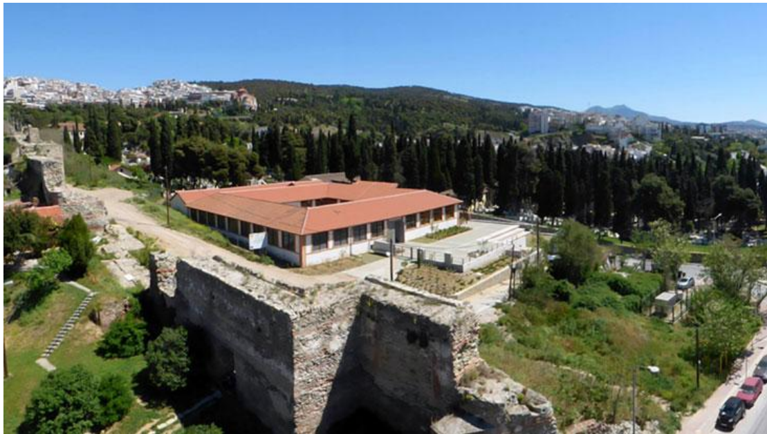
Εργαστήριο της Σχολής Τεχνών και Επαγγελμάτων. Πανοραμική άποψη, μετά το πέρας των εργασιών αποκατάστασης. Διακρίνεται τμήμα του ανατολικού τείχους της πόλης και ο χώρος του ιστορικού νεκροταφείου της Ευαγγελίστριας.
